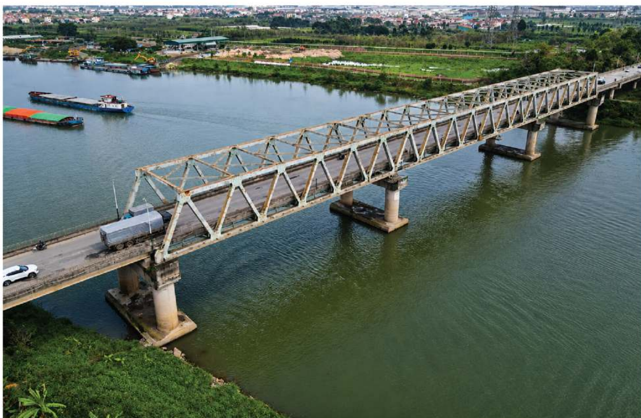
Cầu Hồ Bắc Ninh
